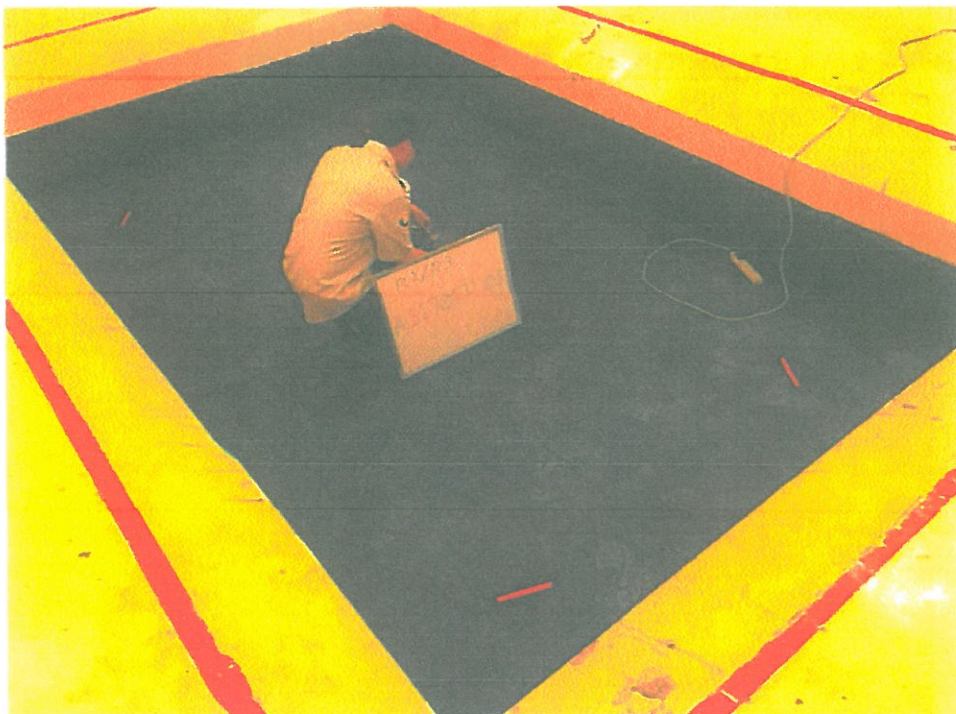
附圖 5：試件施工完成準備測試
