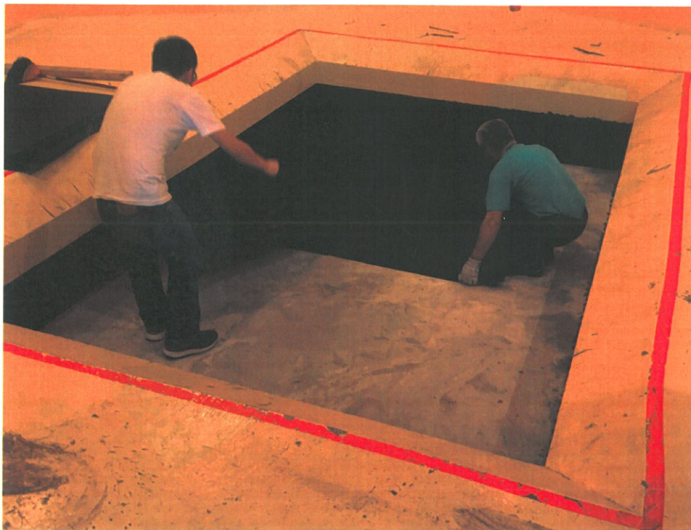
附圖 3：試件安裝施工 (1)
