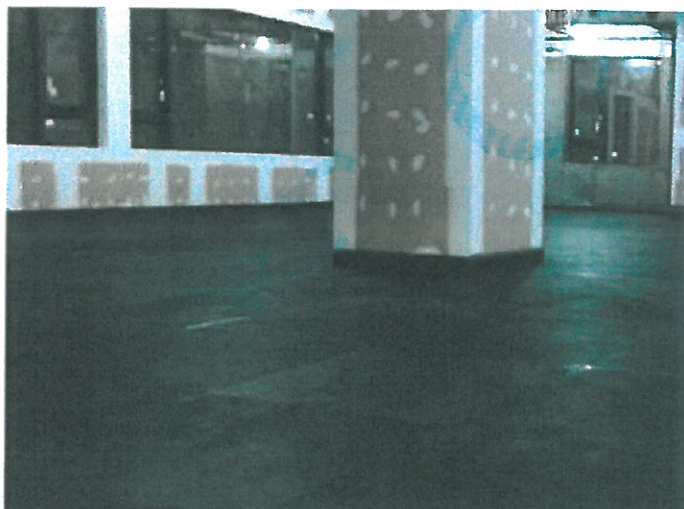
圖 3、測試樓板鋪設隔音墊表面材
