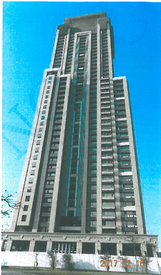
圖 1、新北市新莊區遠雄 95 大樓 (遠雄 H88 新建工程，鋼骨鋼筋混凝土構造，地上 42 層，地下 5 層)
