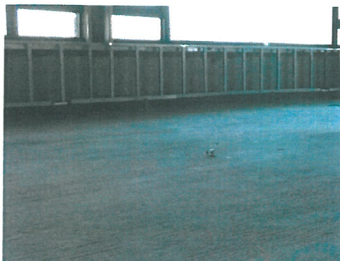
圖 2、測試樓板無鋪設樓板表面材
