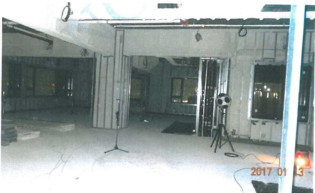
圖 8、測試 24 樓 A3 戶樓板鋪設隔音墊表面材時 受音室(23 樓 A3 戶) 之麥克風量測照片
