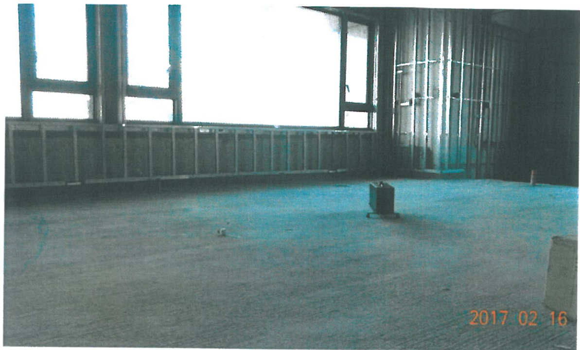
圖 10、測試 25 樓 A3 戶樓板無鋪設表面材時 音源室之標準衝擊音源敲擊照片
