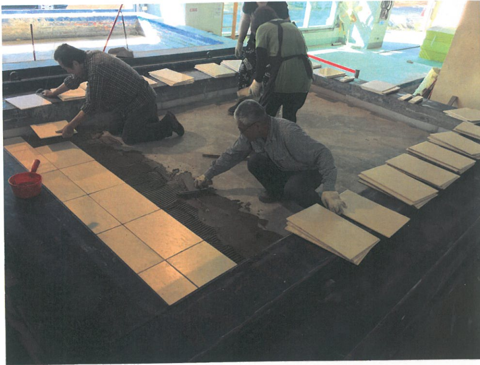
附圖 4：試件安裝施工 (2)
