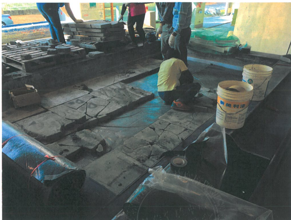
附圖 3：試件安裝施工 (1)
