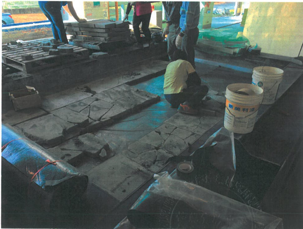
附圖 3：試件安裝施工 (1)
