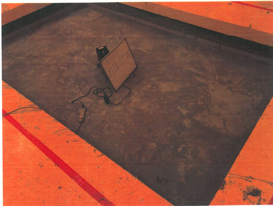
附圖 5：試件施工完成準備測試
