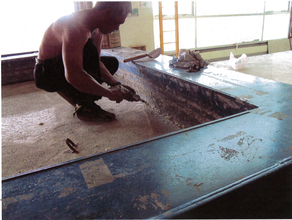
附圖四：試件安裝施工（2）
