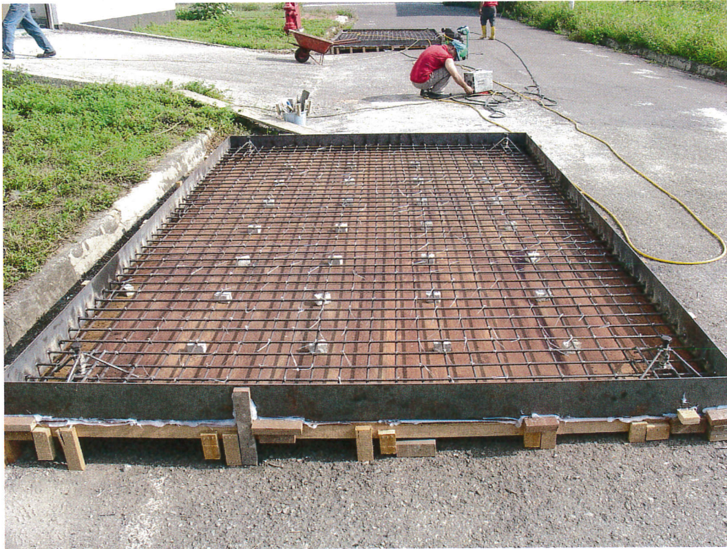
附圖二：15cm 標準樓板施工
